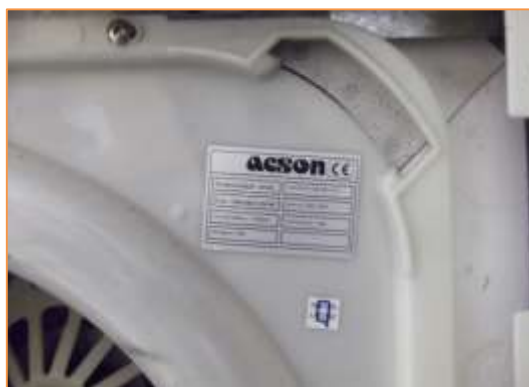
Imagen 6 Equipos de producción de frío y calor para climatización. - Sistema autónomo de expansión directa tipo BdC - Split ACSÓN.
