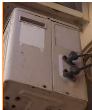
Imagen 5 Equipos de producción de frío y calor para climatización. - Sistema autónomo de expansión directa tipo BdC - Split DAITSU.
