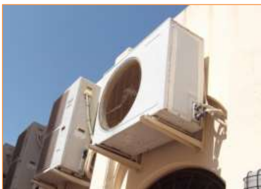
Imagen 6 Equipos de producción de frío y calor para climatización. - Sistema autónomo de expansión directa tipo BdC - Split ACSÓN.
