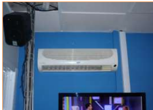
Imagen 9 Tipología de unidades interiores instalada. Pared .
