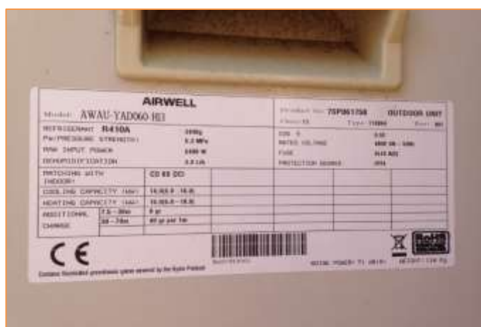
Imagen 4 Equipos de producción de frío y calor para climatización.- Sistema autónomo de expansión directa tipo BdC - Split AIRWELL.
