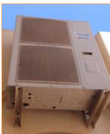
Imagen 4 Equipos de producción de frío y calor para climatización.- Sistema autónomo de expansión directa tipo BdC - Split AIRWELL.
