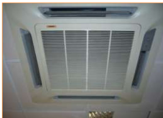
Imagen 10 Tipología de unidades interiores instaladas. Cassette .
