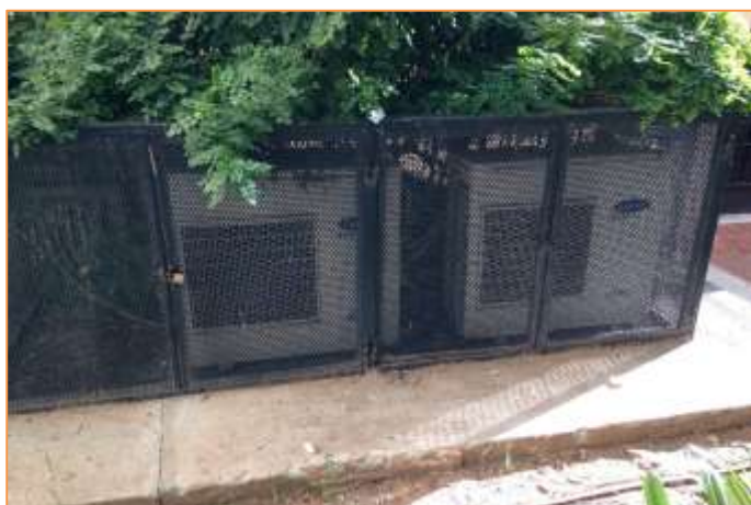
Imagen 7 Equipos de producción de frío y calor para climatización. - Sistema autónomo de expansión directa tipo BdC - Multi-split CARRIER
