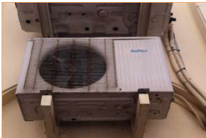
Imagen 5 Equipos de producción de frío y calor para climatización. - Sistema autónomo de expansión directa tipo BdC - Split DAITSU.
