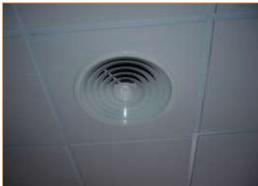
Imagen 8 Tipología de unidades interiores instaladas. Conductos .
