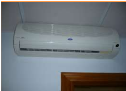
Imagen 9 Tipología de unidades interiores instalada. Pared .
